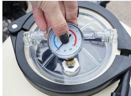
Bild 7 b Manometer eindrehen
